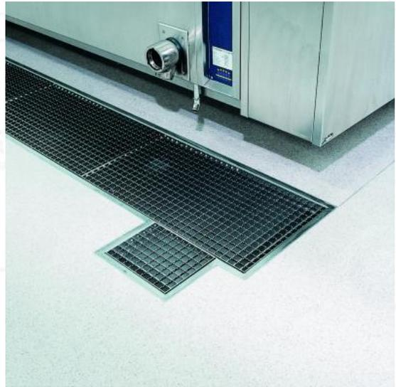
fugenlos, dichte Kastenrinne aus V2-A-Stahl
