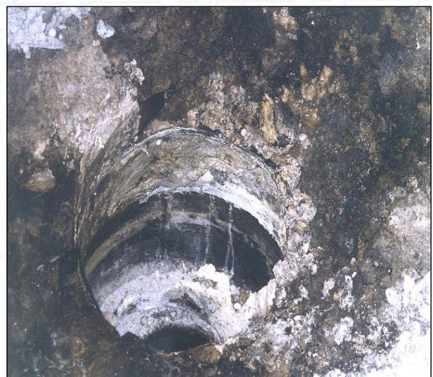
Durchnässte Bodenkonstruktion am Abgang einer Kastenrinne
