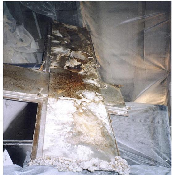
Undicht, eingebaute Edelstahlrinne
